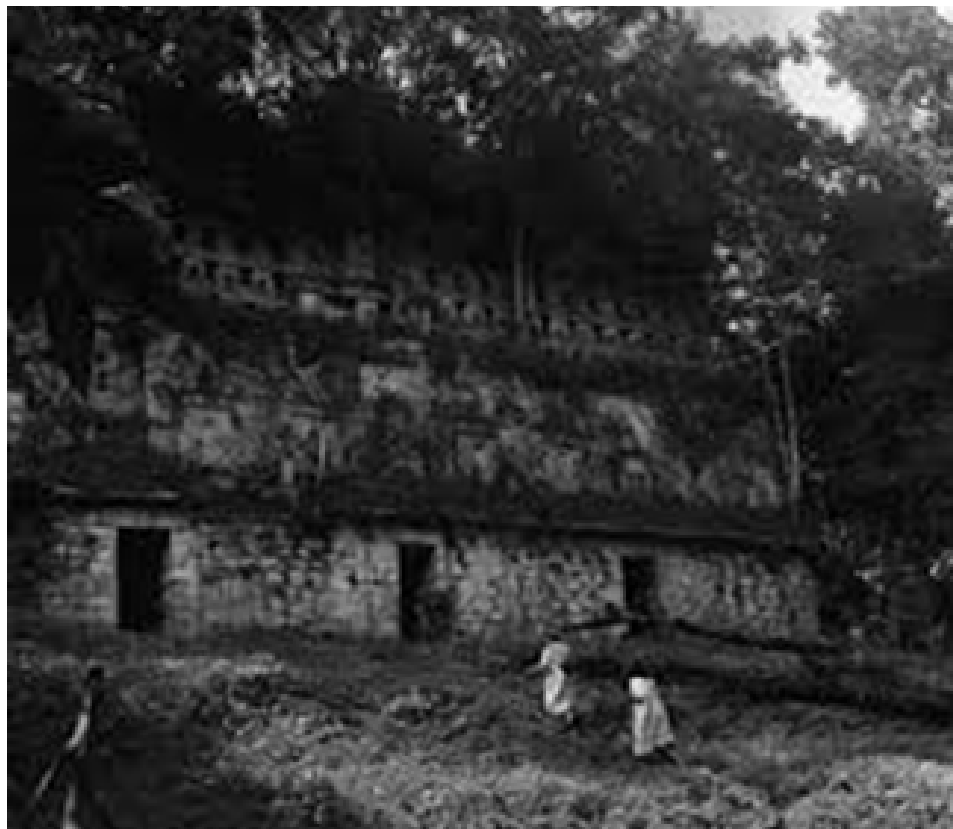
Templo 33 antes de ser excavado
