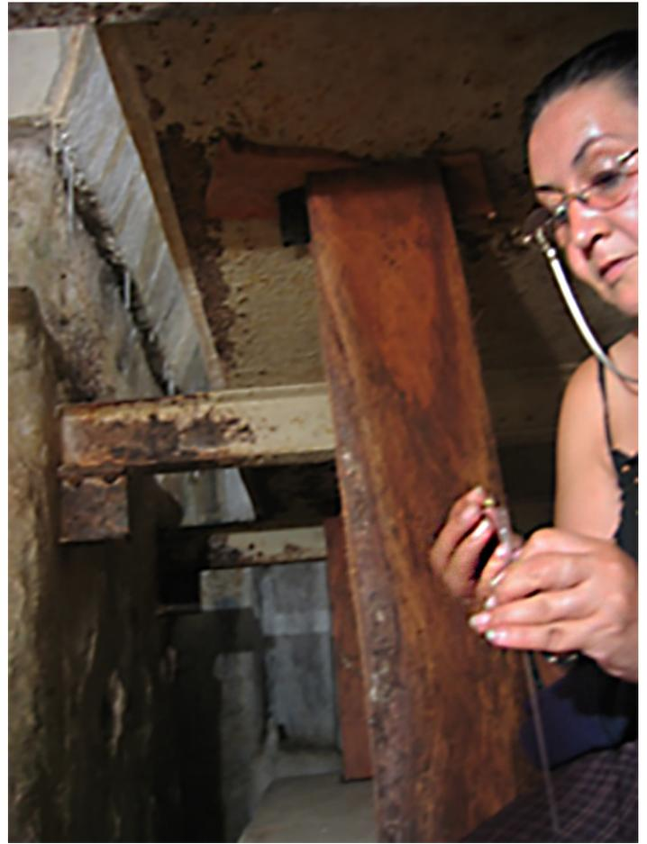
**Toma de muestras realizada por la Lic. en Rest, Martha I. Tapia donde se observa las vigas de metal y los postes de madera que se colocaron como refuerzo**
