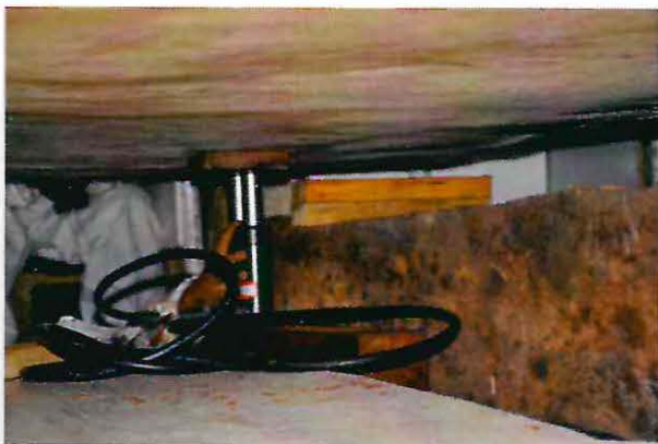
Gato hidráulico y polines de madera que apoya por debajo de la lámina
