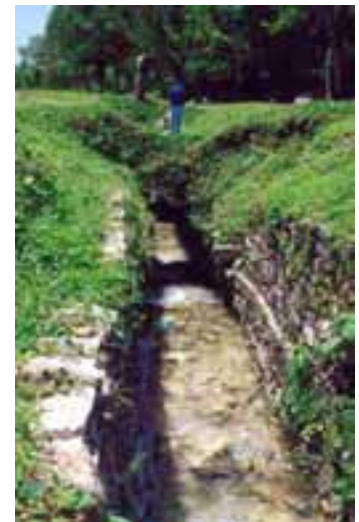
Detalle del acueducto de Palenque ubicado en el extremo sureste del Palacio.
