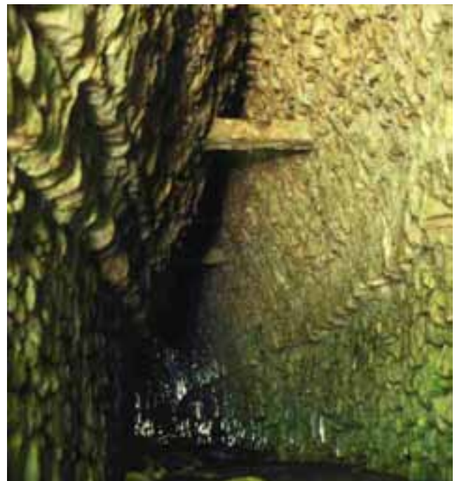
Figura 2. Acueducto subterráneo del Palacio de Palenque.
