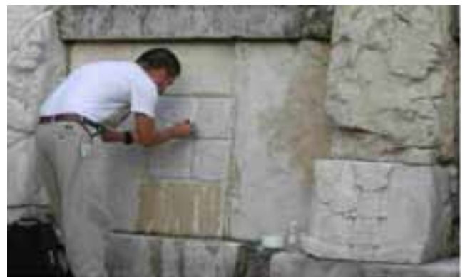
Aplicación de capas de protección de cal y mármol para evitar pérdidas del relieve.
