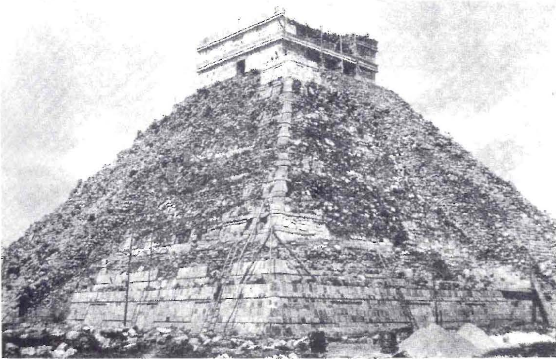
Greene supuso que los edificios de Yucatán eran más monumentales que los de Palenque. Trabajos de consolidación en el Castillo de Chichén Itzá (1931-1936), a cargo de José Erosa Peniche.
