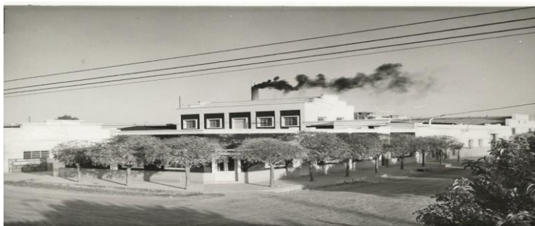
Figura 3. Fábrica de Sancor, s. f. Fuente: Archivo Histórico Municipal de Brinkmann.
