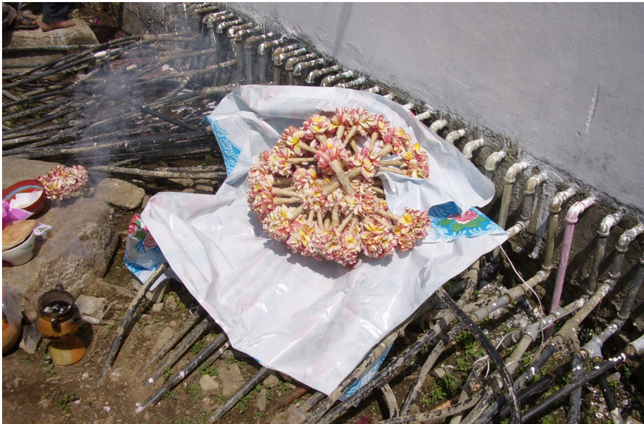
Figura 5. Manantial entubado con las tomas de agua y un arreglo de xochimakpali. Fotografía: Eliana Acosta.
