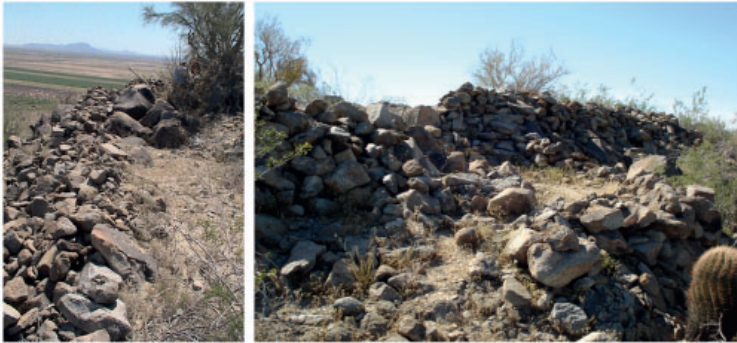
FIGURA 15. Muro este (izquierda) y acceso noroeste (derecha) de la estructura vistos de norte a sur. Archivo PRACBRA, 2008.
