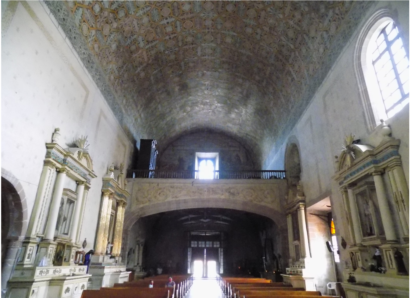
La bóveda después de la restauración; vista hacia el coro. Fotografía: Gabriel Rivera
