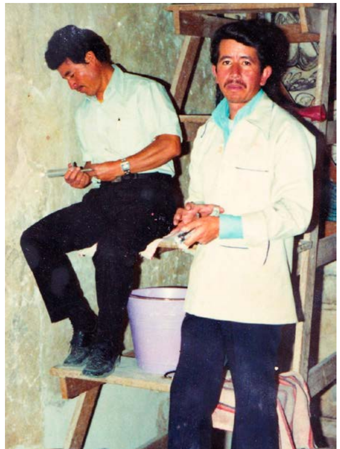
Alberto León Islas consolida los aplanados de los muros de la sala de Profundis del convento de Actopan. Fotografía: Colección particular. Ca. 1993.
