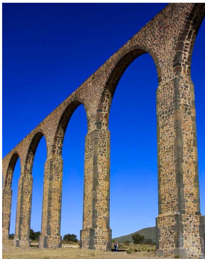
Sección del acueducto Padre Tembleque o de Zempoala. Fotografía: Héctor Álvarez Santiago
