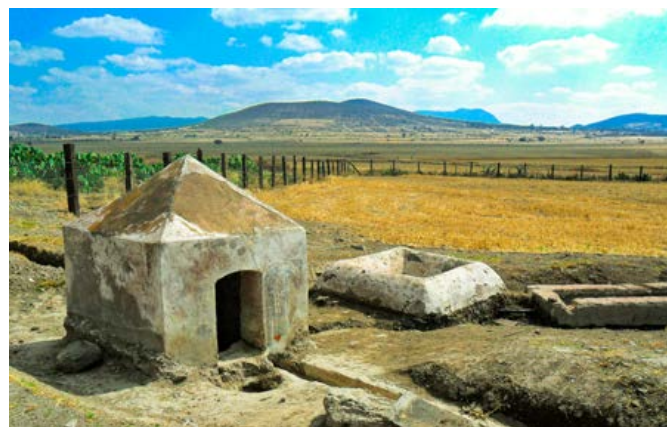
Caja y arenero del acueducto del Padre Tembleque en el tramo ubicado en la hacienda de Guadalupe Arcos. Fotografía: Roberto Hernández Juárez
