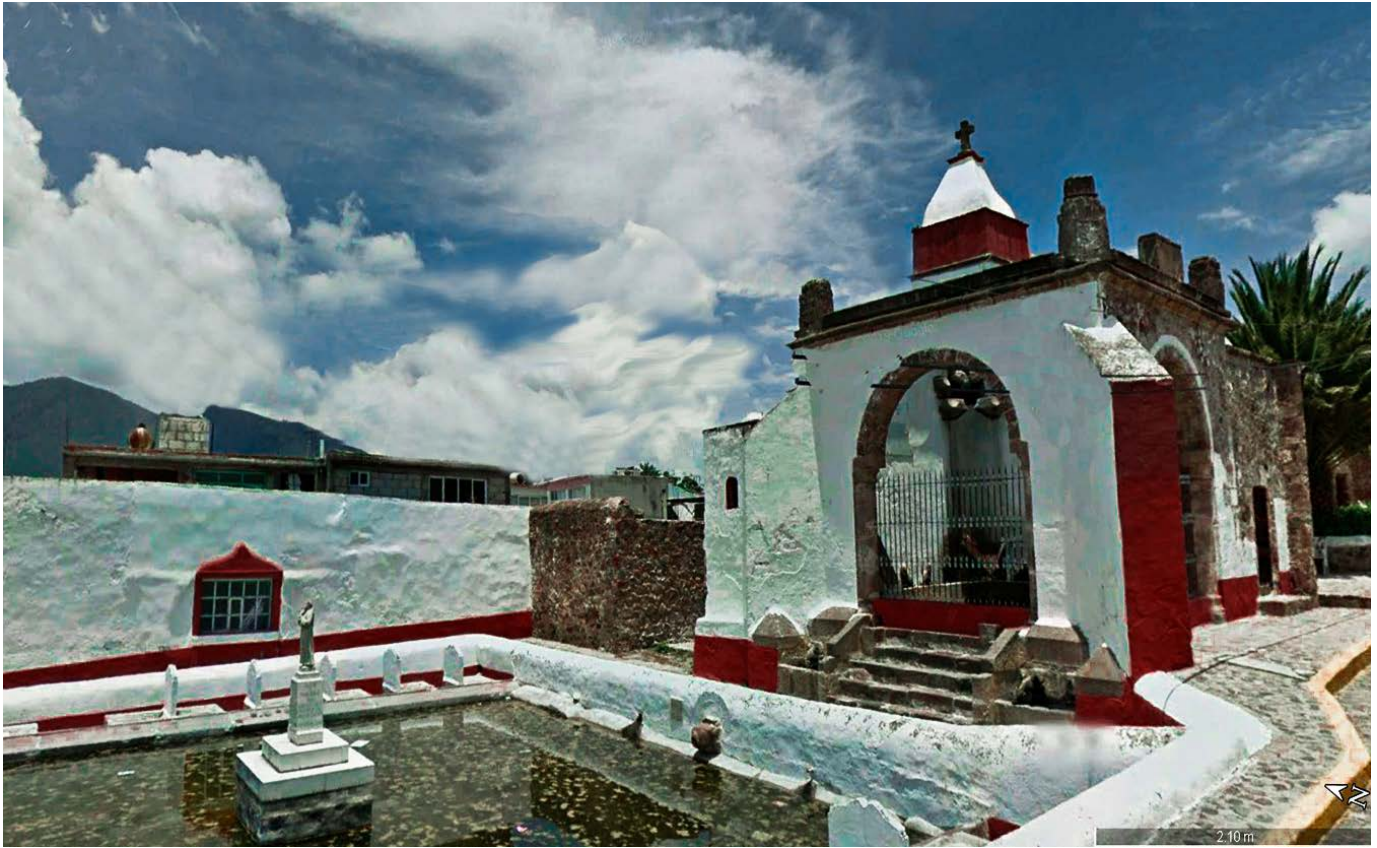
Caja de Agua del acueducto de Tepeapulco. Fotografía: Sergio Camarena Villaseñor
