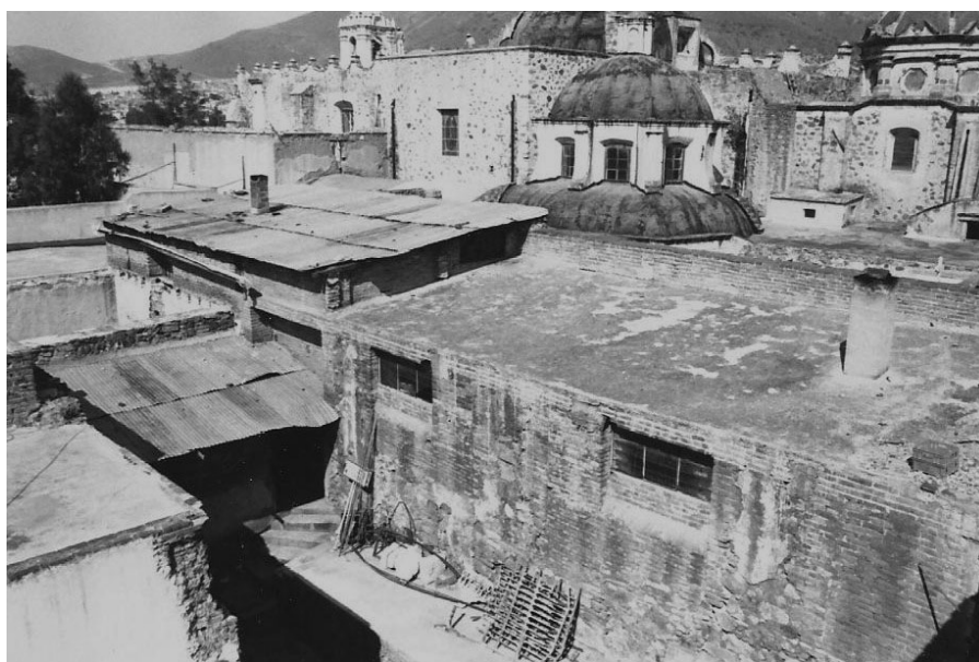
Los espacios de la dirección del Centro INAH Hidalgo (izquierda) y del taller de restauración (derecha) antes de su reconstrucción entre 1983 y 1984. Fotografía: José Vergara Vergara
