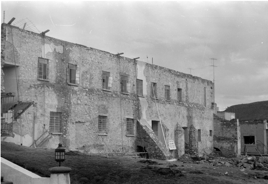
Retiro de aplanados de la fachada poniente del convento y colegio de San Francisco, durante los trabajos de reconstrucción de 1979 a 1980. Fotografía: José Vergara Vergara
