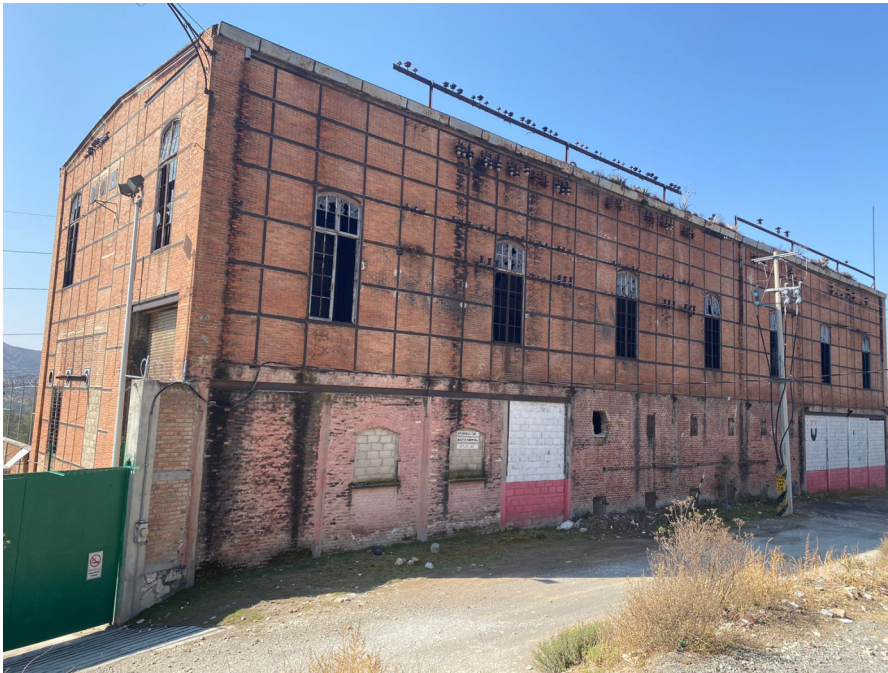
Subestación eléctrica de la mina de Dos Carlos. Fotografía: Stephany Espinosa Guerrero
