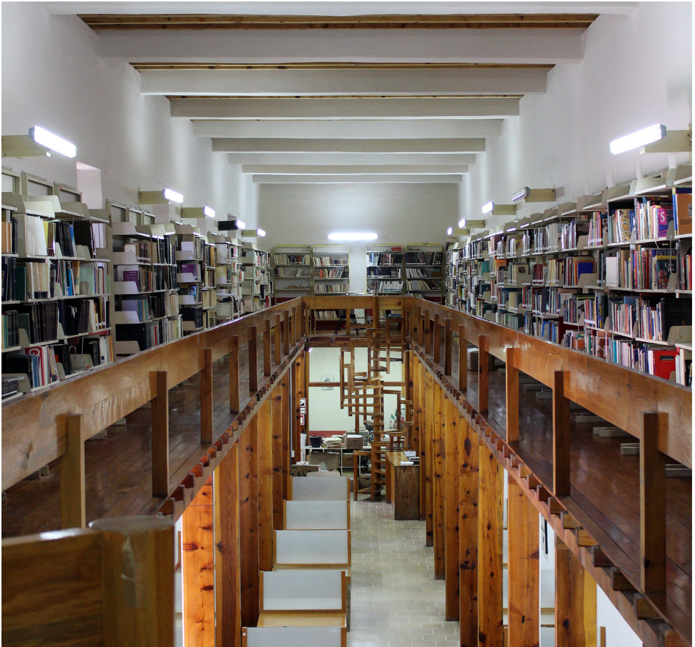
Biblioteca Antonio Peñafiel, imagen tomada en los días inmediatos a la terminación de la restitución de la techumbre. Fotografía: José Vergara Vergara. 2021
