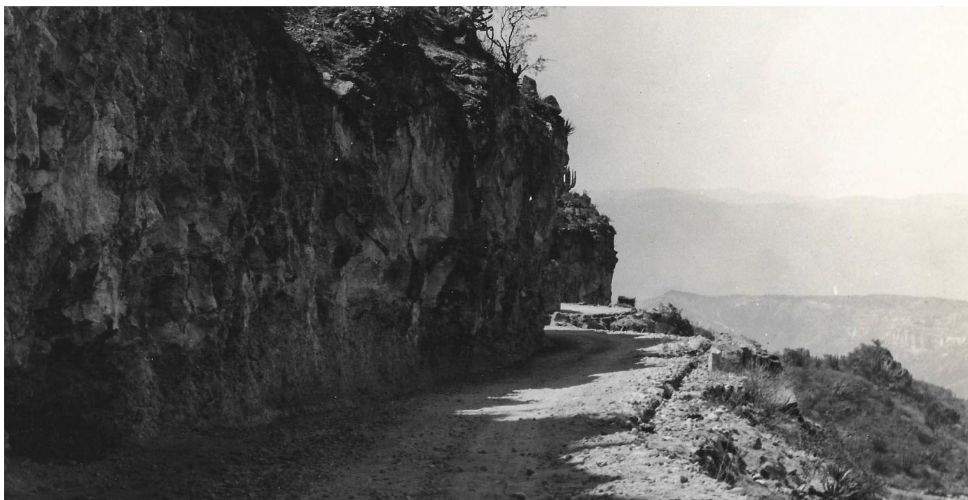
La construcción de caminos en zonas montañosas implica un esfuerzo mayor, así como herramientas adecuadas para despejar de rocas la ruta trazada. Foto L. Márquez. Ca. 1956. Colección particular.
