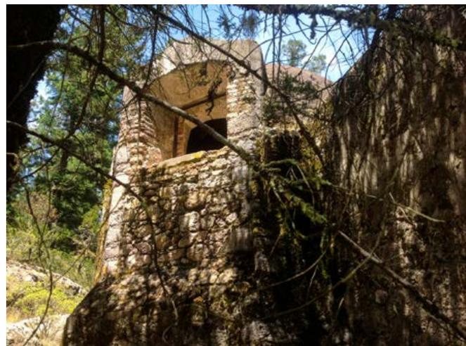
*Sobre el trayecto del acueducto se localizan estas cajas de agua, para redireccionar y amortiguar la corriente acuifera.
