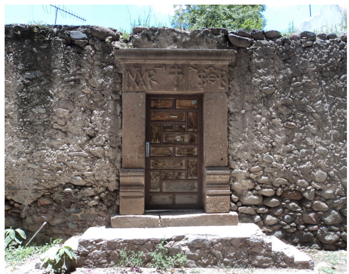
Ejemplos de dinteles monolíticos de cantera labrada con cornisa y nomograma en alto o bajo relieve, vinculado a una cruz que se levanta en el centro. En el primer caso con un esgrafiado inferior donde se ubica con letras rústicamente garigoleadas la fecha abril de 1728, “A 3 de Abril de 1728 AC
