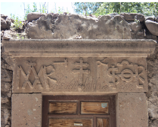
Ejemplos de dinteles monolíticos de cantera labrada con cornisa y nomograma en alto o bajo relieve, vinculado a una cruz que se levanta en el centro. En el primer caso con un esgrafiado inferior donde se ubica con letras rústicamente garigoleadas la fecha abril de 1728, “A 3 de Abril de 1728 AC
