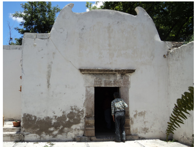
Fachada de capilla doméstica con acceso frontal con jambas y dintel de cerramiento a base de sillares de cantera labrados que exhibe un remate semicircular, ubicada en la llamada Calle Oscura, Tecozautla, Hgo.
