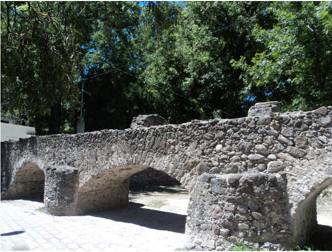
Tramo longitudinal del acueducto conocido como los "Arcos" que soportan el canal de la Unidad de Riego Chichimequillas-Pathecito, obra de infraestructura hidráulica del siglo XVIII (1702).
