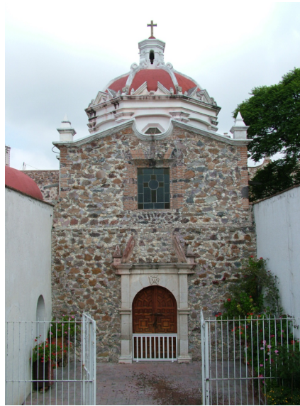
Fachada de la capilla de Nuestra Señora de la Luz. Arriba del frontón, en el paramento se aprecia el soporte de la viguería de la techumbre que cubría la antecapilla; año de 2017. Fotografía: José Vergara Vergara
