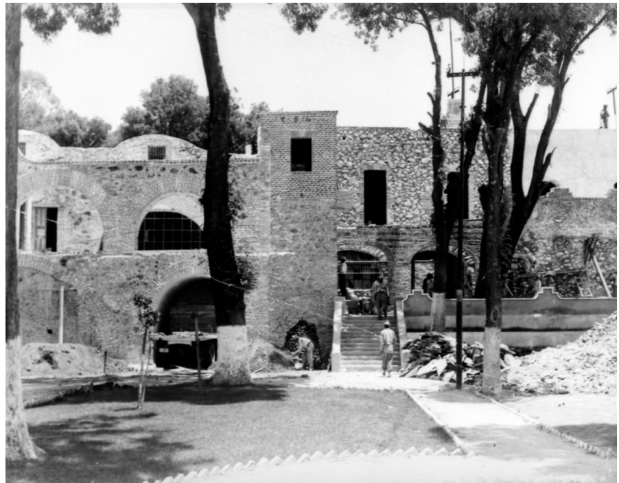
Trabajos de reconstrucción del área ocupada entre 1861 y 1936 por el Hospital Municipal y posteriormente por el Hospital Civil de Pachuca; ca. 1956. Fotografía: INAH. SINAFO.FN.MX. Cat. 298647
