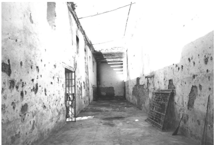
Interior de la crujía norte, antes de su reconstrucción entre 1983 a 1984 para la biblioteca Antonio Peñafiel. Fotografía: José Vergara Vergara
