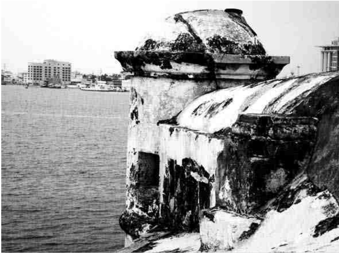
Foto 10. Garitón antes de aplicar el mortero.
