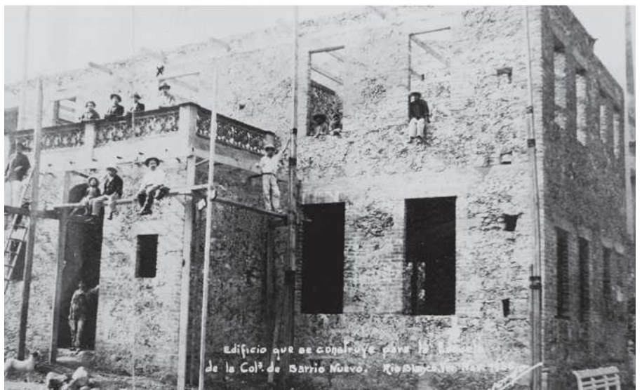
Escuela en construcción en la Colonia Barrio Nuevo de Río Blanco, 1936 (FIM, 2007)
