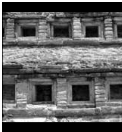
En su arquitectura sobresalen los elementos nicho y cornisa
