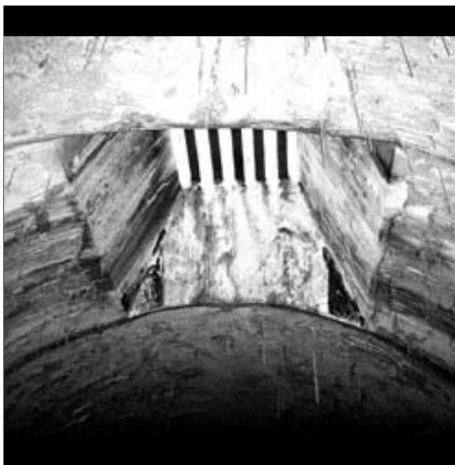
Fotografía 2. Formación de estalactitas en el interior de una galería en San Juan de Ulúa.
