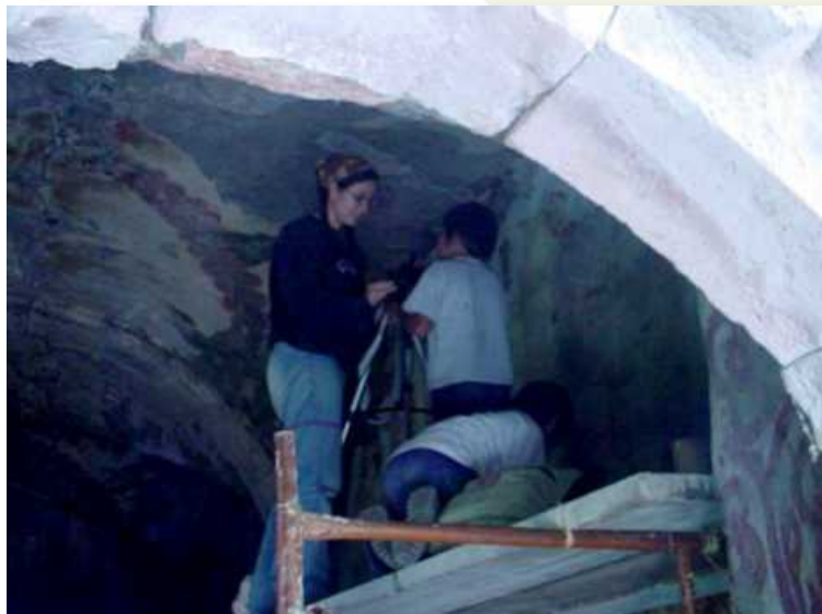
Trabajos de limpieza y consolidación de la Capilla Familiar de los Ángeles
