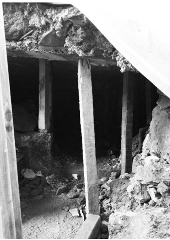
Techo apuntalado para el rescate de materiales. San Gregorio Atlapulco, noviembre de 2017.
