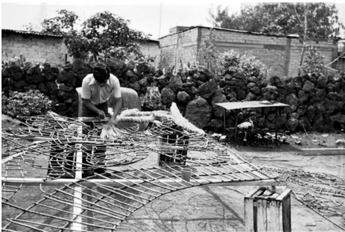
Armado de la estructura de la portada floral. Fotografía © Patricia Peña Haaz (ca. 1972).
