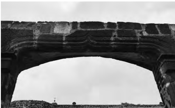
Puerta lateral con arco conopial Fotografía © AFCCC
