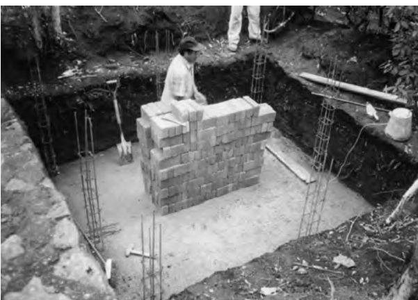
Mantenimiento y drenes Fotografías © AFCCC
