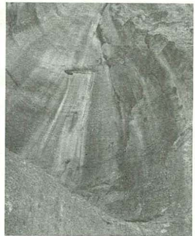
Socavón. La Pintada. Foto: César Villalobos
