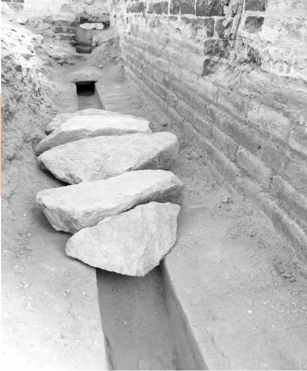
Detalle de las piedras que sirven como tapa del canal (izquierda) y detalle del registro del drenaje número 8. Sótano entrada, bodegas de arqueología (derecha). Fotos: S. Adrián López Dávila.
