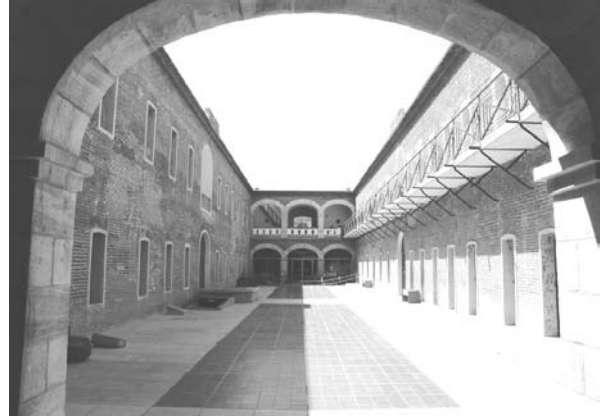
Patio central actual de la Penitenciaría Foto: Mauricio Marat
