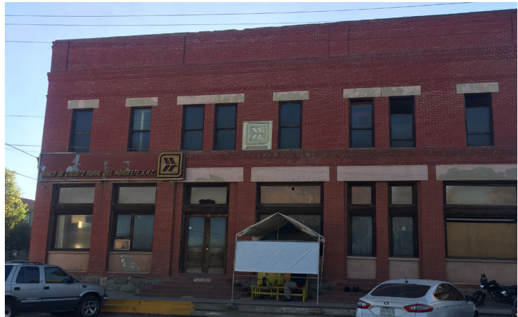
EDIFICIO BANRURAL, CANANEA, 2021. FOTOGRAFÍA VERÓNICA GUTIÉRREZ.
