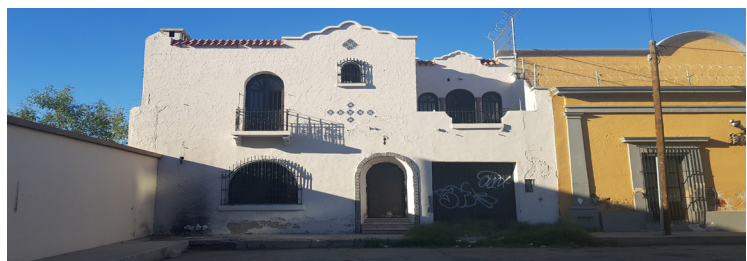
EDIFICIO CONOCIDO COMO LA ANTIGUA ALIANZA FRANCESA, HERMOSILLO, 2020. FOTOGRAFÍA ANABEL LEYVA HERNÁNDEZ.
