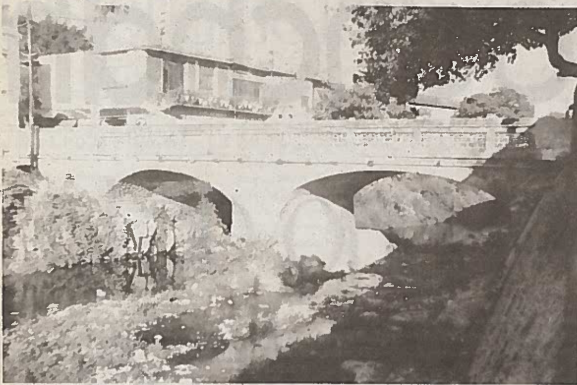
Puente principal sobre el río Yautepec construido en el siglo XVII y ampliado en el XIX, un verdadero monumento histórico. (foto: César Ortíz).
