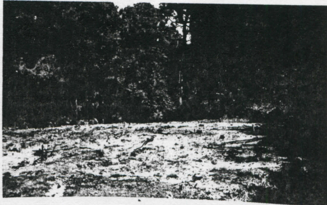
Limpia de terreno en fraccionamiento. Foto: Emiliano Melgar.
