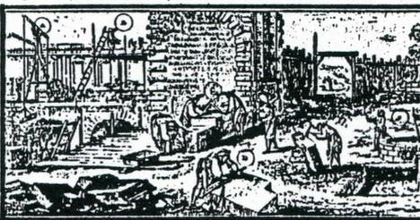
LAMINA EN la cual se muestran las diferentes tareas desempeñadas para la construcción de un edificio: a) montacarga para subir materiales b) albañiles c) nivelación para el desplante de un muro d) trazo con regla y compás e) corte de piedra con pico f) batidores de meollo g) corte con sierra h) transportador de meollo y otros materiales para la construcción.
