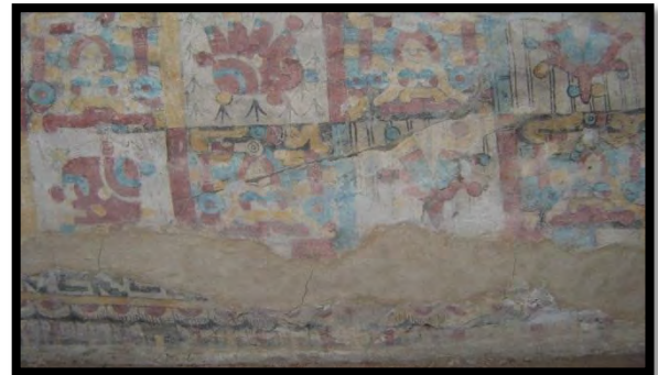
Figura 3. Deterioro en el lado este del Mural B de Tizatlán.
