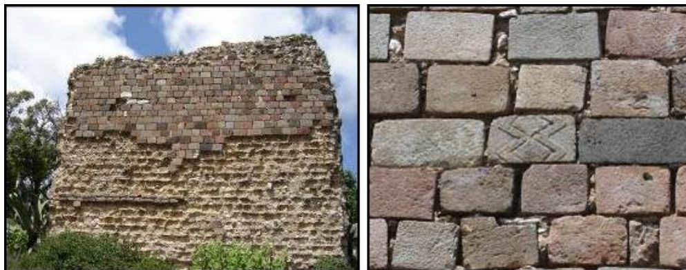
Figura 4. Vista general del paramento oriente y detalle del sillar con glifo.
