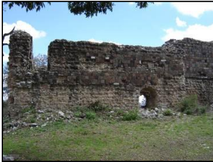
Figura 13. Vista general del muro sureste.
