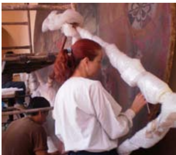
Figura 7. Limpieza de la capa de protección de "La lactación de Santo Domingo".
