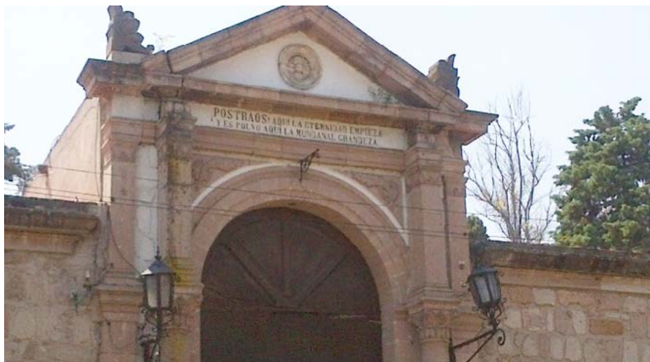
Figura 1 Puerta principal del Panteón Civil Municipal de Morelia. 1
